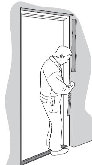
Hele spalteybden mellom karmen og veggene skal dyttes med ikke-brennbar isolasjon, euroclass A1, ev. A2-s1 d0.
